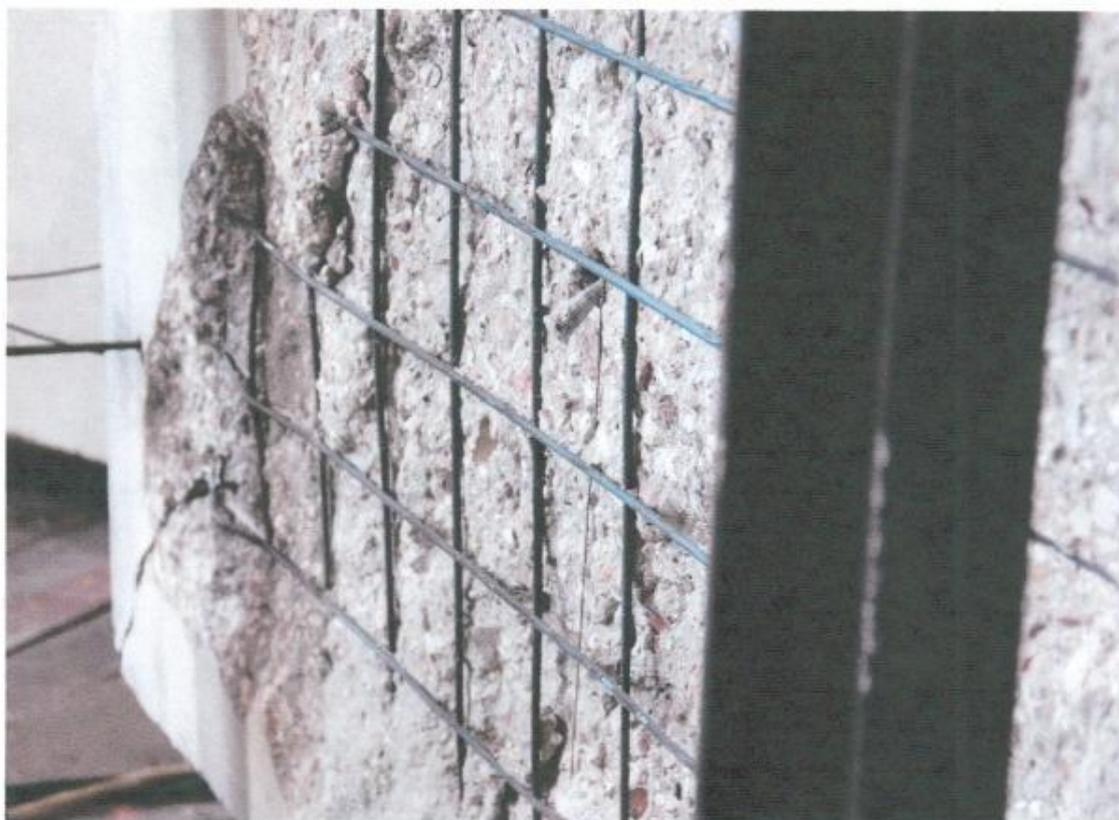
Рисунок 3.11 – Обнажение арматуры после термического воздействия
